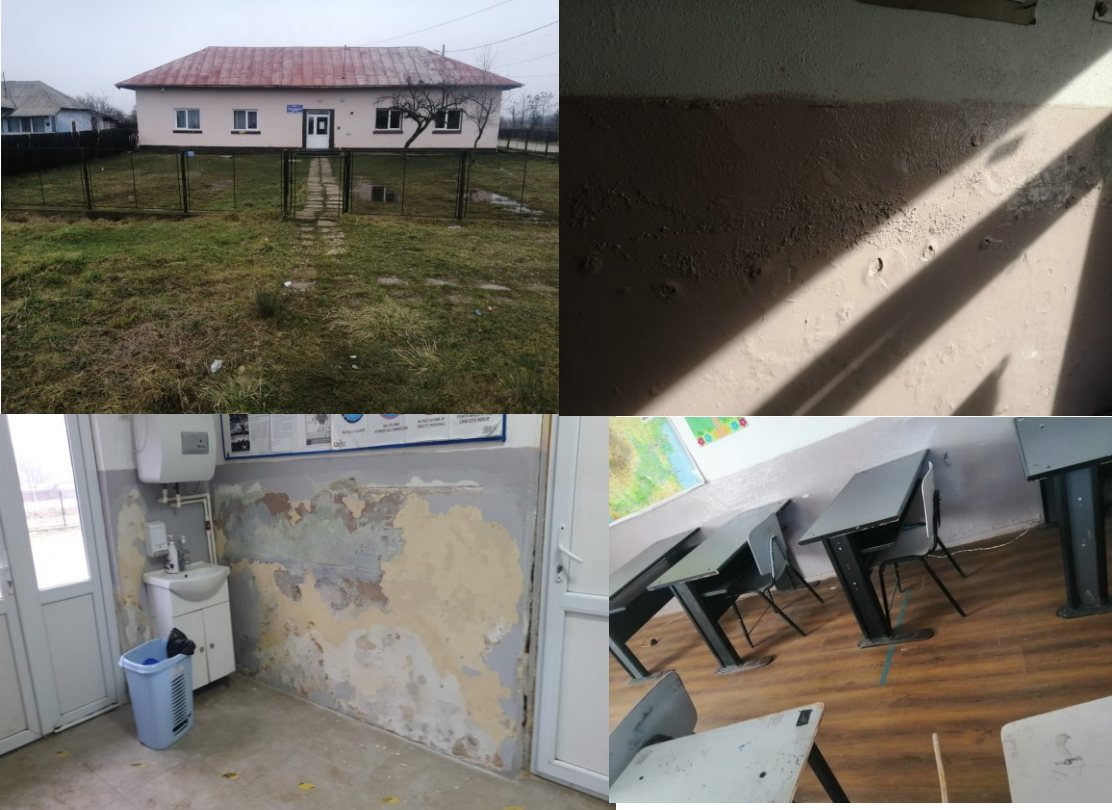
Inainte de renovare
